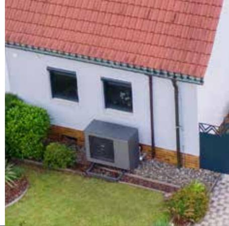
neuen Fenstern wurde an der Bausubstanz oder Innenausstattung nichts geändert, die Röders heizen weiterhin mit klassischen Heizkörpern. Um bei guter Energiebilanz die dafür nötigen Vorlauf-temperaturen von 55 °C sicherzustellen, entschied man sich für ein Dimplex System E Pure Wärmepumpensystem. Dieses arbeitet auch bei höheren Vorlauftemperaturen effizient, sehr leise und ließ sich platzsparend vor der Hauswand im Garten aufstellen.
